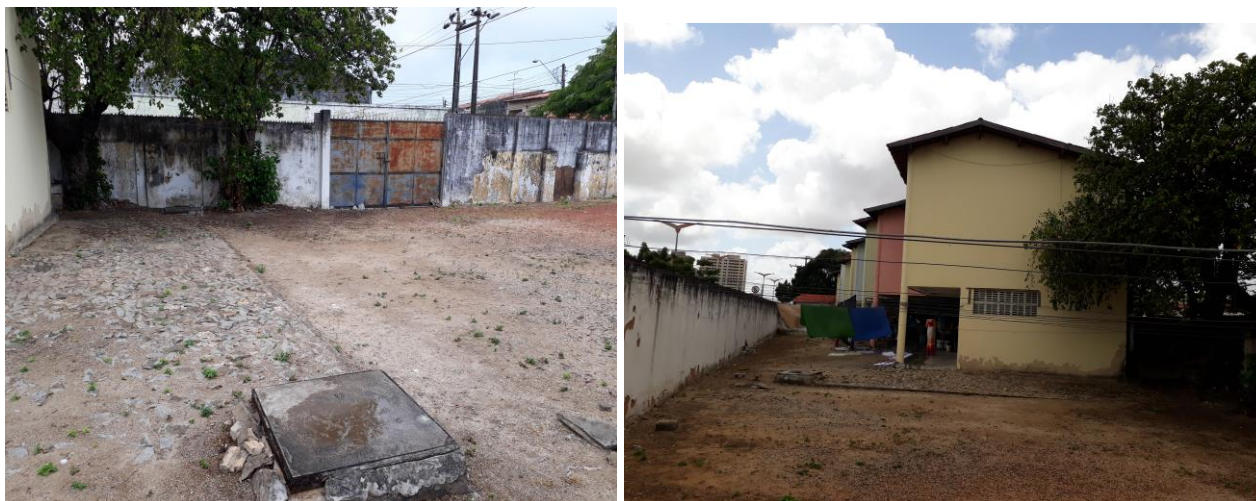
Imagens 04 e 05 – Área destinada às futuras Instalações da Lavanderia Comunitária; Fonte: SEINF.
